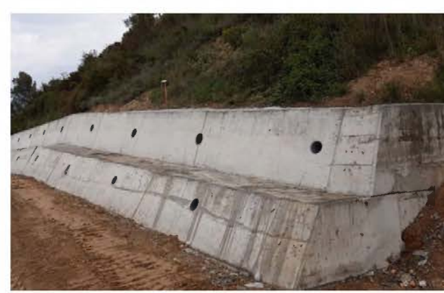
Hormigonado de la estructura de anclajes.
