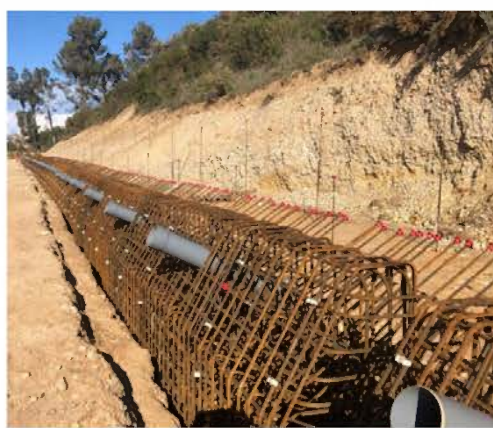
Disposición de anclajes para la disposición de carga del tesado.
