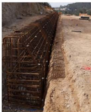
Estructura de acero para puntos de anclaje.
